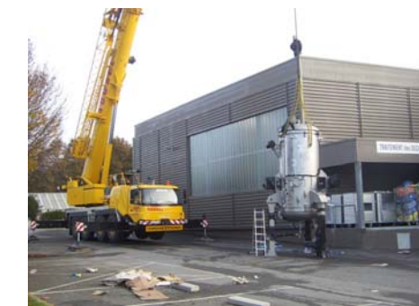
13 novembre 2008 : livraison du 2 ème banaliseur
